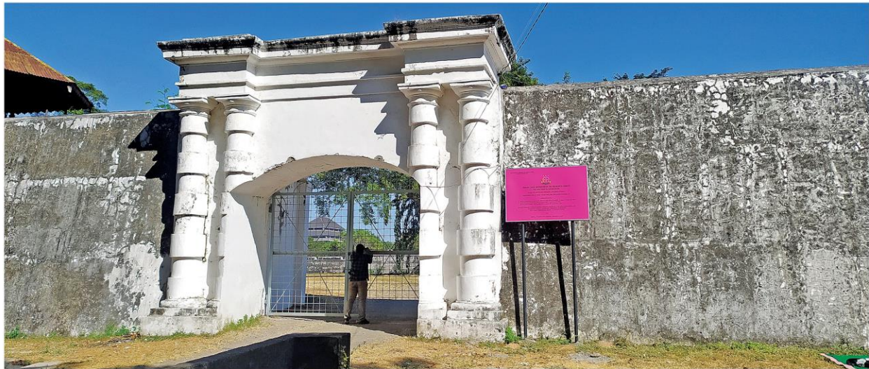
DISITA - Papan pengumuman berwarna merah muda penyitaan Benteng Vastenburg Solo terpasang di dekat bangunan bersejarah tersebut, Kamis (27/7).
